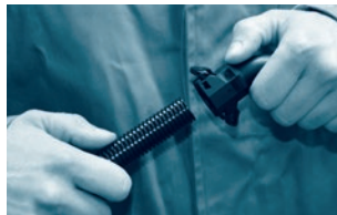
Schritt 5: Wellenschlauch aus Verschraubung ziehen.
